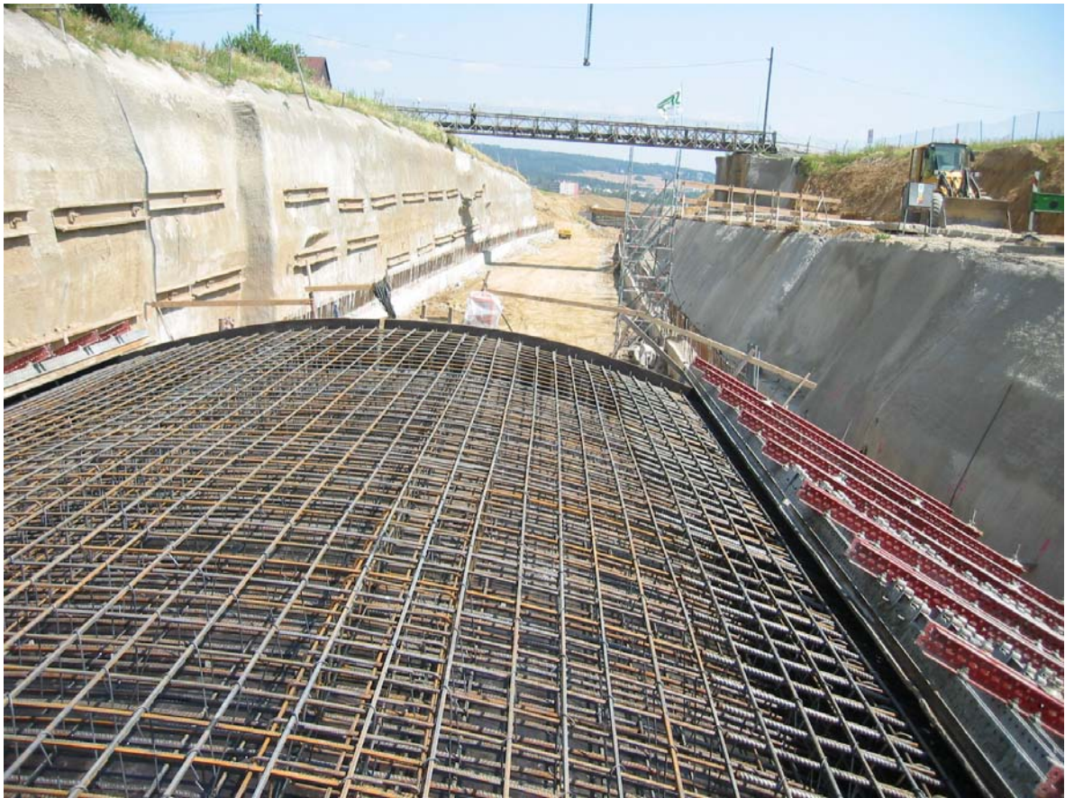
Obr.1 Stavební jáma pro provádění milánských stěn a betonáž klenby
