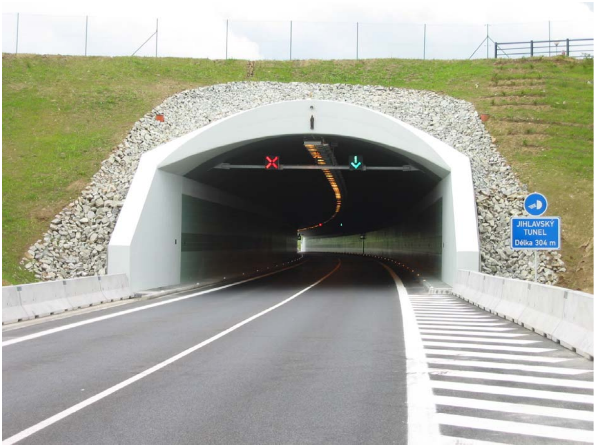
Obr.3 Hotový tunel před spuštěním provozu
