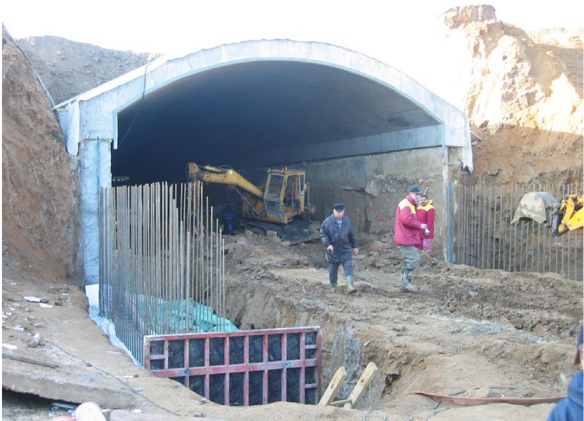
Obr.2 Hloubení tunelu pod ochranou milánských stěna klenby
