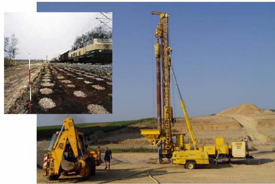
Obr. 3. Příklad instalace ŠP pilířů
